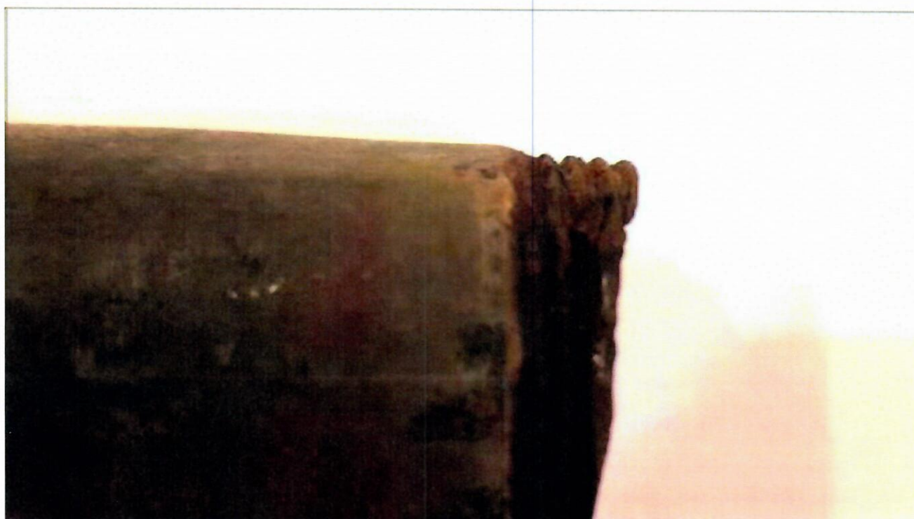
ФОТО 23 (вид резьбовой части трубы Ду32)
