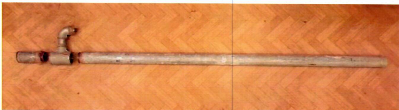
ФОТО 41 (рассоединенные резьбовые соединения тройника и труб Ду32)
