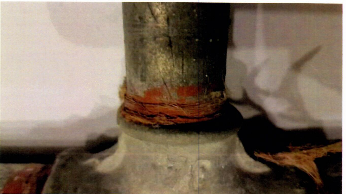
ФОТО 32 (пряди льняного уплотнителя, выступающие наружу из резьбового соединения )
