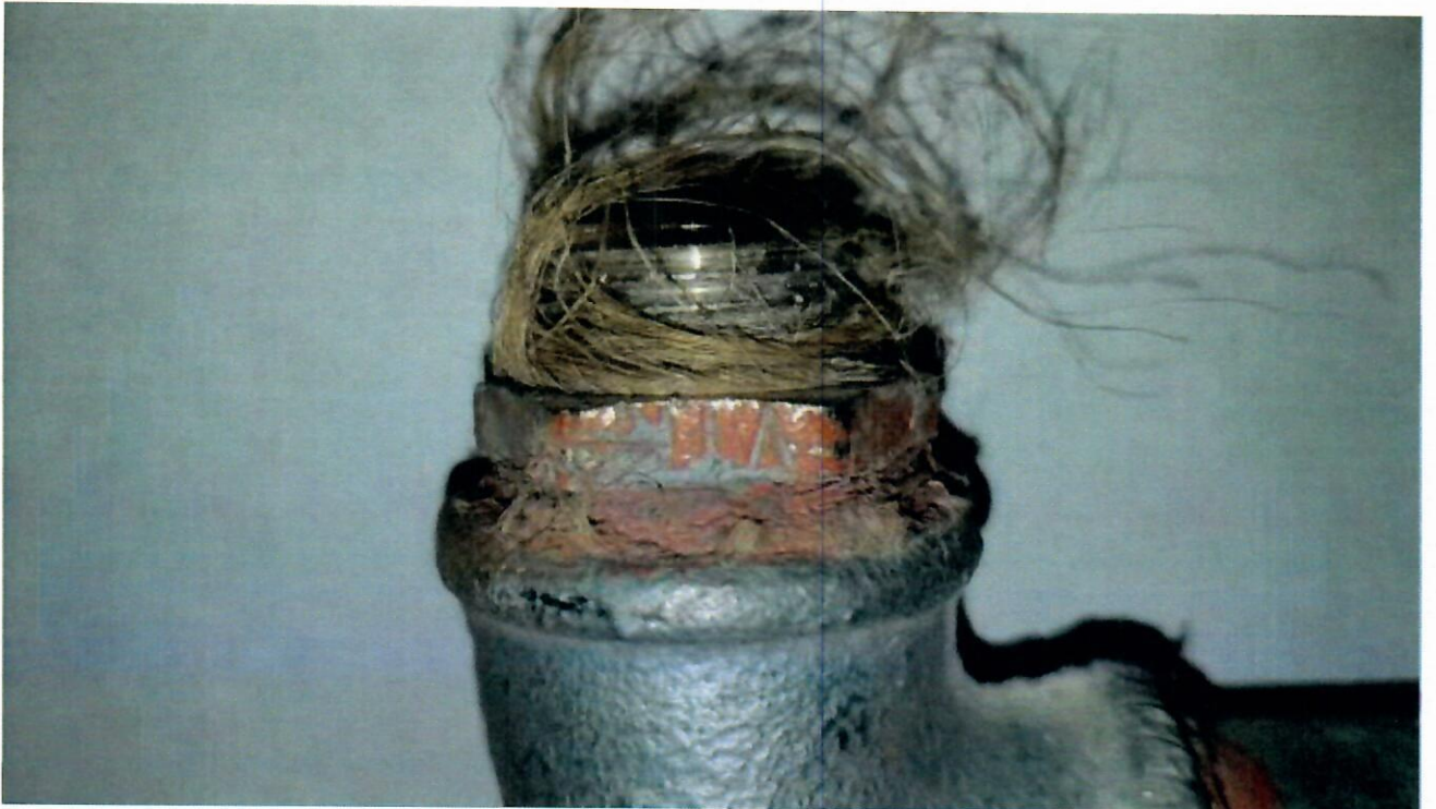
ФОТО 35 (пряди льняного уплотнителя, выступающие наружу из резьбового соединения )
