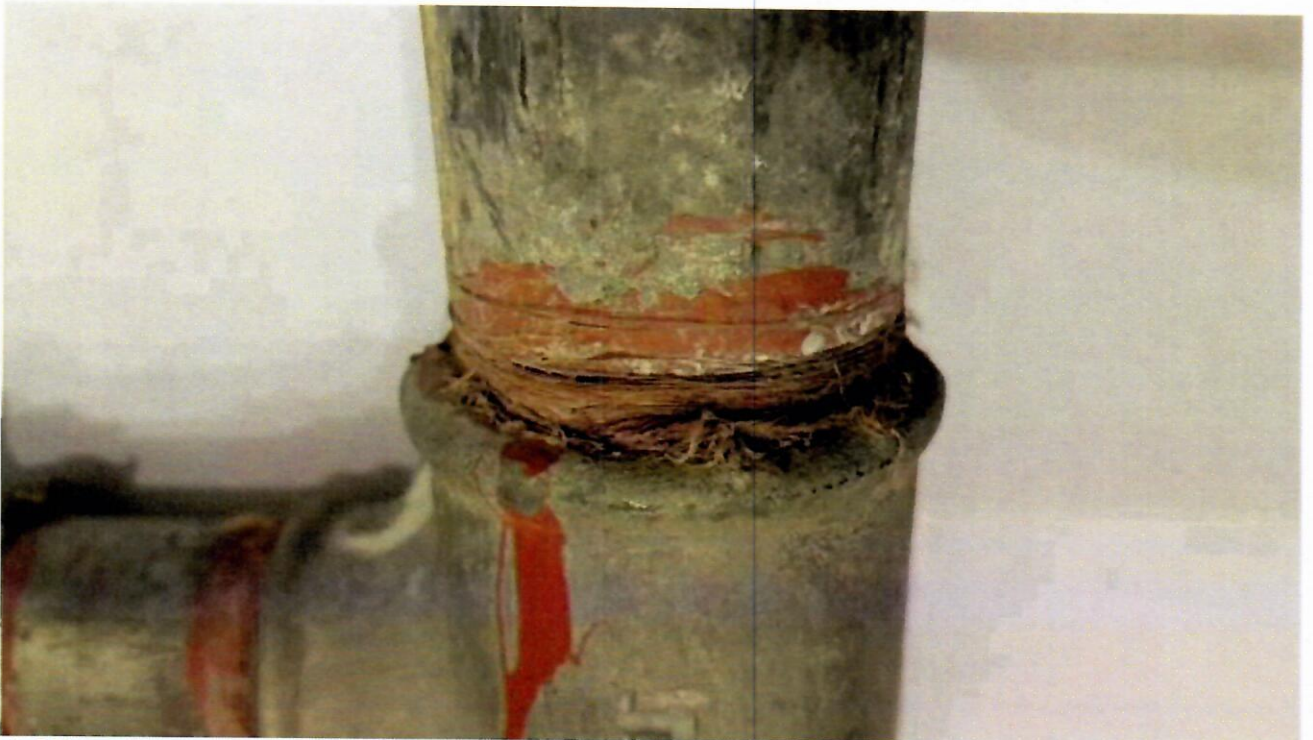
ФОТО 31 (пряди льняного уплотнителя, выступающие наружу из резьбового соединения )
