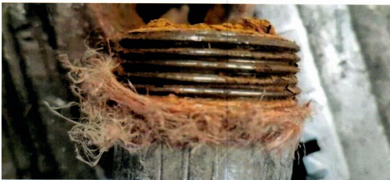
ФОТО 40 (вид резьбы на трубе Ду 32)
