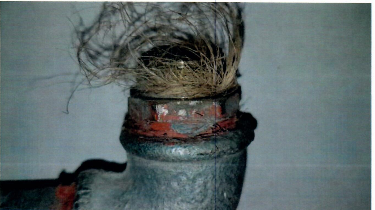
ФОТО 34 (пряди льняного уплотнителя, выступающие наружу из резьбового соединения )
